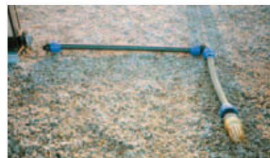
Montagem da tubagem de sucção
